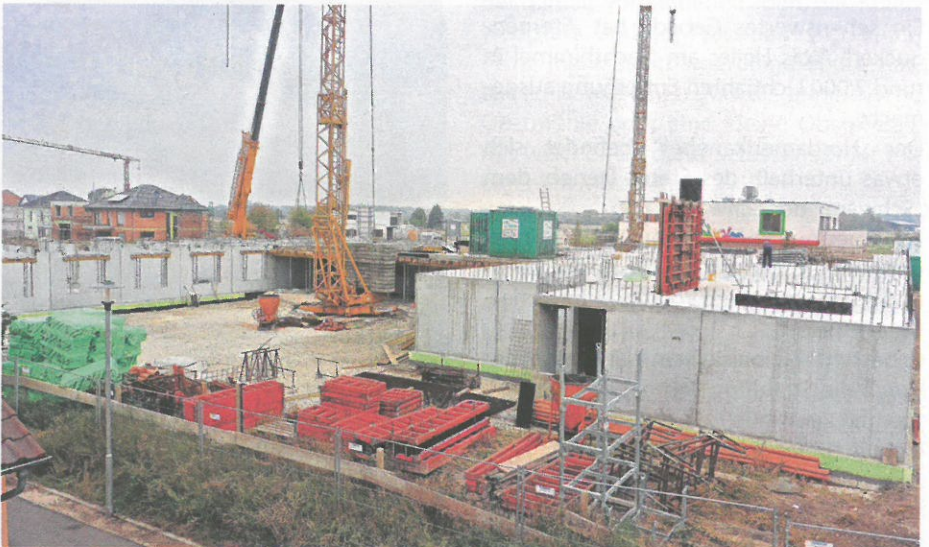
Das ganze Ausmaß des beachtlichen Baukörpers wird allmählich sichtbar.
