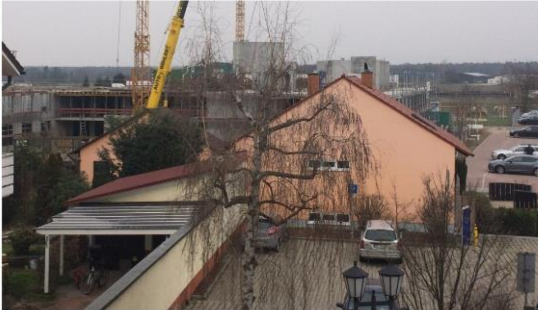
Blick vom Rathaus auf die Baustelle
