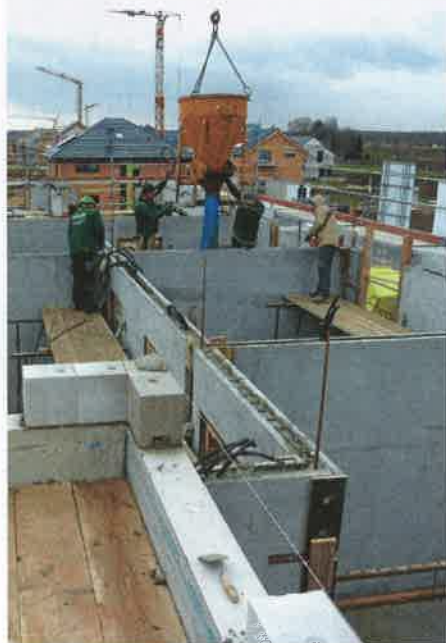
Die Hohlräume der zweischaligen Innenwände werden mit Beton verfüllt
