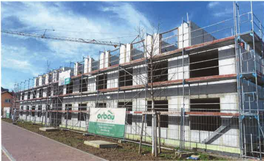
Der Rohbau kommt mit dem Attikageschoss in seine Endphase
