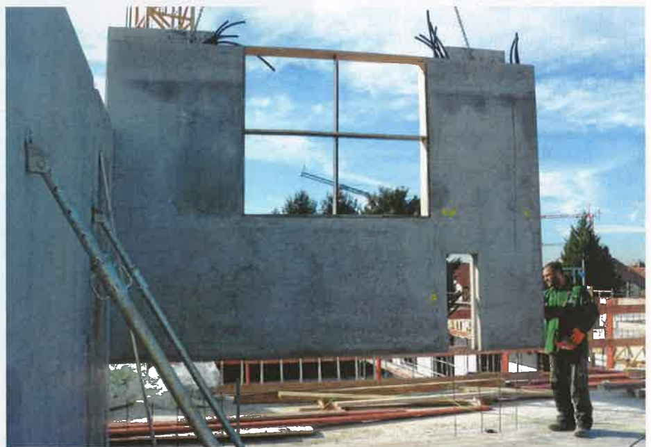
Vorproduzierte Beton-Elemente beschleunigen den Bauablauf
