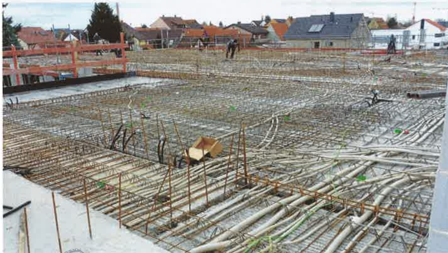
Ein Gewirr von Leerrohren durchzieht die Stahlbeton-Fertigteildecke, bevor der Ort beton aufgebracht wird
