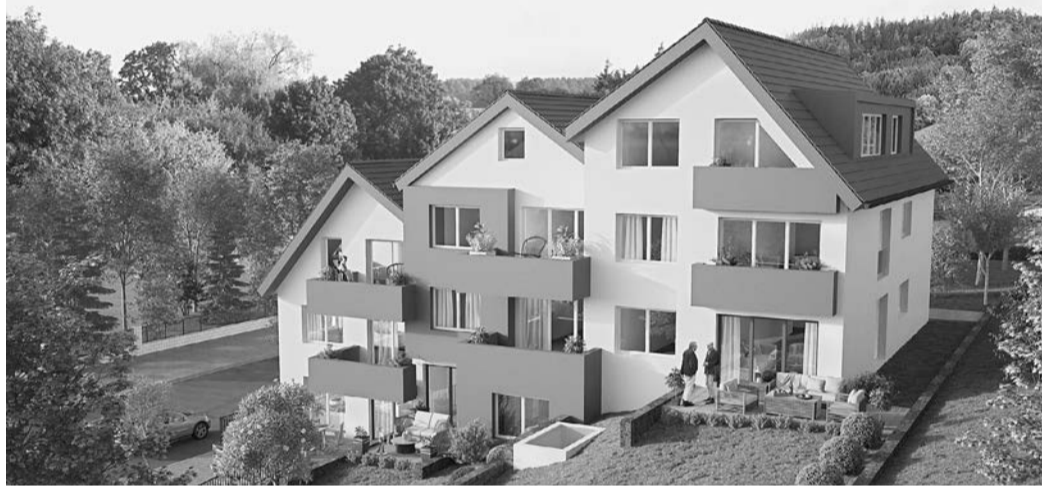
Gegliederte Bauweise: Der Baukörper folgt dem natürlichen Geländeverlauf. Die entstehenden Wohnungen sind zueinander jeweils halbgeschossig versetzt.
