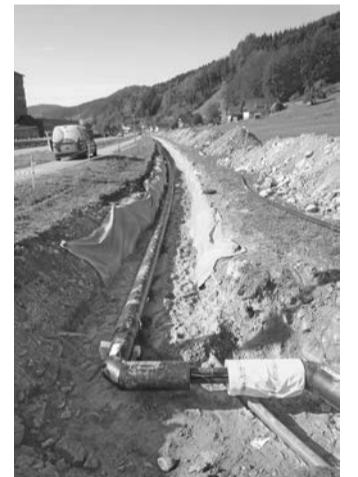
Die Fernwärmeversorgung von Nordrach geht weiter voran. Nächstes Ziel ist der Ortsteil Allmend.
