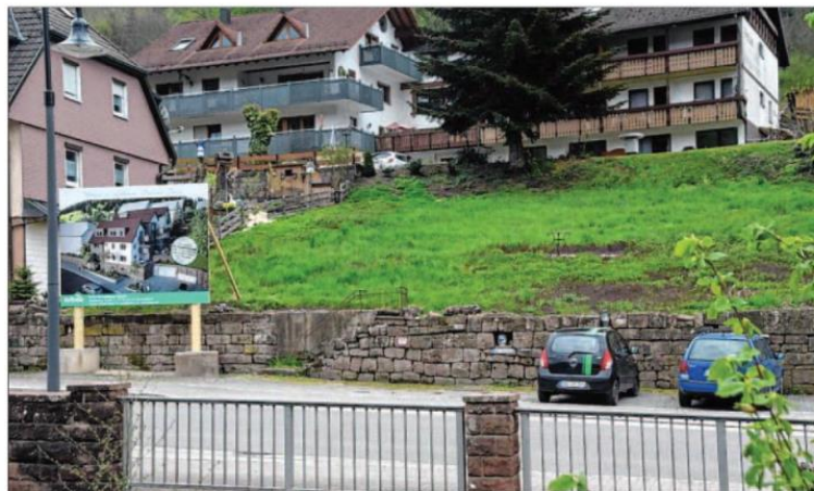
Das Schild steht bereits und zeigt, wie sich die Baukörper später mal im Gelände darstellen werden. Insgesamt neun Eigentumswohnungen sollen entstehen.
