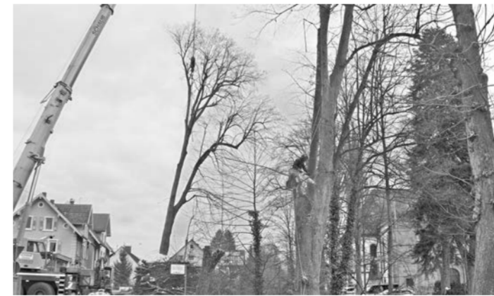
Am Haken des Autokrans schwebten die großen Baumteile auf die Straße herunter.
