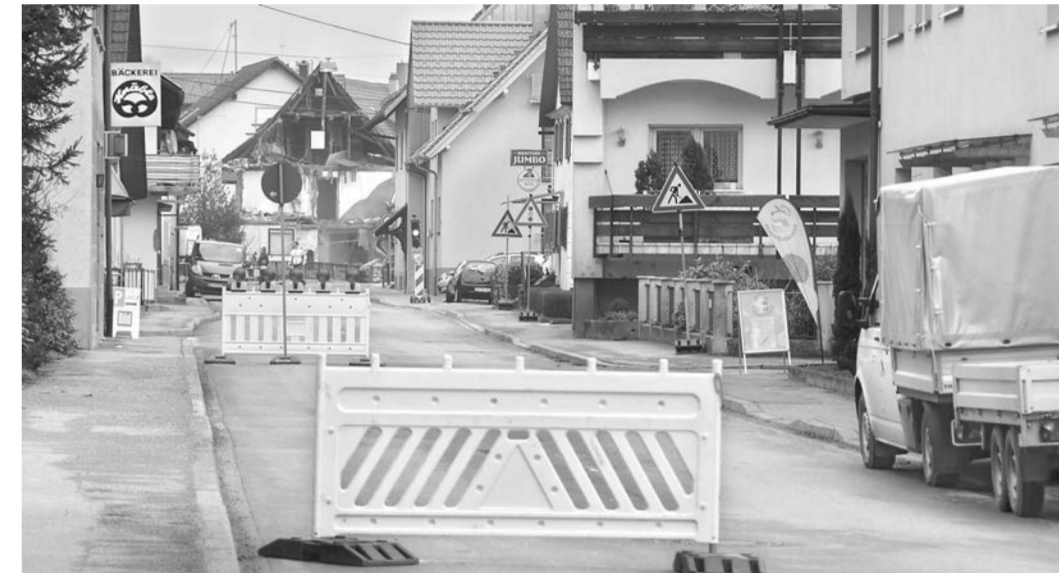
Mit der Vollsperrung des Streckenabschnitts von der Wallfahrtskirche bis zum Gasthaus »Ochsen« gab es einen Vorgeschmack auf die Großbaustelle. Fotos: Hanspeter Schwendemann
