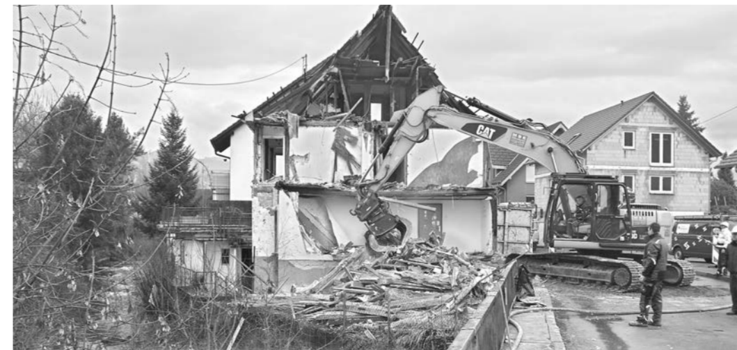
Auch das Haus direkt oberhalb der Kaffeebrygg wurde am Samstag abgerissen. Das Bauunternehmen nutzte die Straßensperre für ungehindertes Arbeiten.
