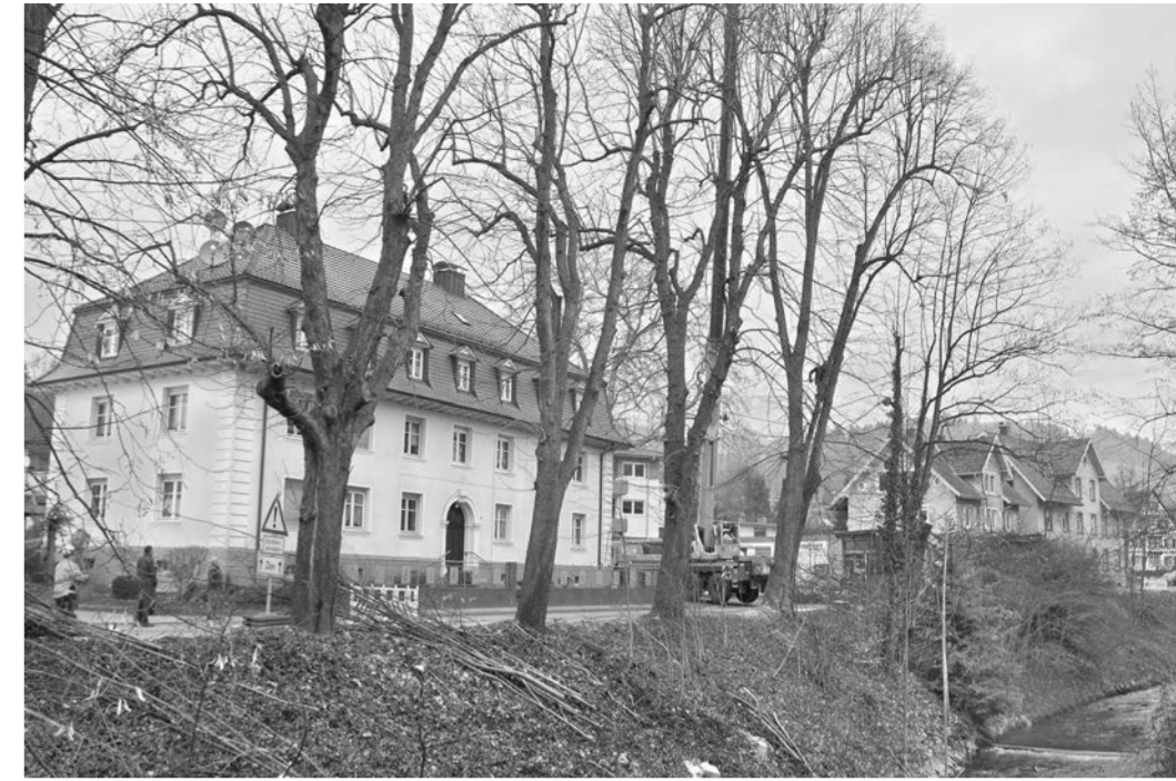
Am Samstag hatte die letzte Stunde für die Kastanien entlang der Hauptstraße geschlagen. Sie mussten dem bevorstehenden Ausbau der L 94 und der Sanierung der Kanalisation weichen.
